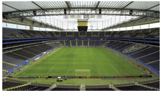
Das Faltdach ist über dem Videowürfel untergebracht
