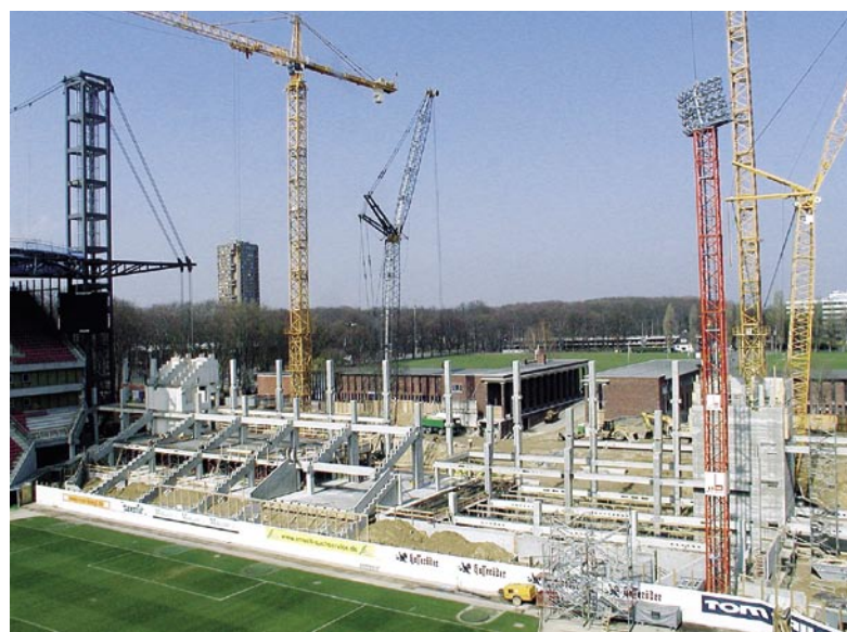
Fertigteilmontage im Norden
