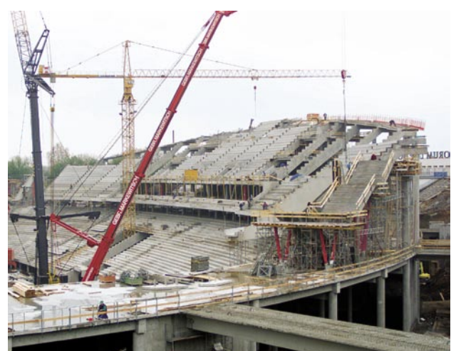
Fertigteilmontage
