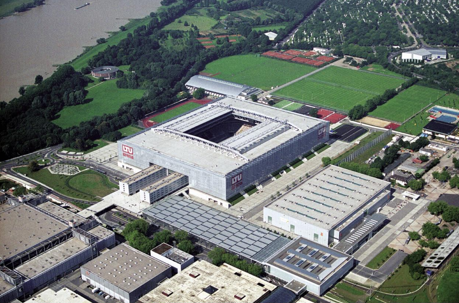
Nah am Rhein und in den Messe-Komplex integriert: Die LTU arena – hier mit geöffnetem Dach
