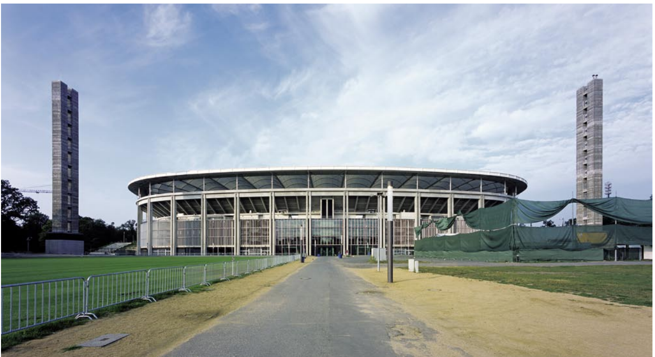
Die Stelen sind mit Fertigstellung des Stadions noch nicht verkleidet
