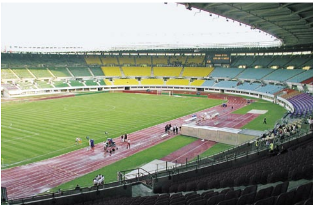
Wien: Ernst-Happel-Stadion Status: Erneuter Umbau für die EM Architekten: Otto Schweizer (1929-1931 erbaut) Baukosten: – Kapazität: 53.008 (nur Sitzplätze) Spiele: 7 (u. a. Finale)
