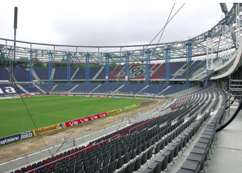
Temporäre Sichtbehinderung durch Stütztürme
