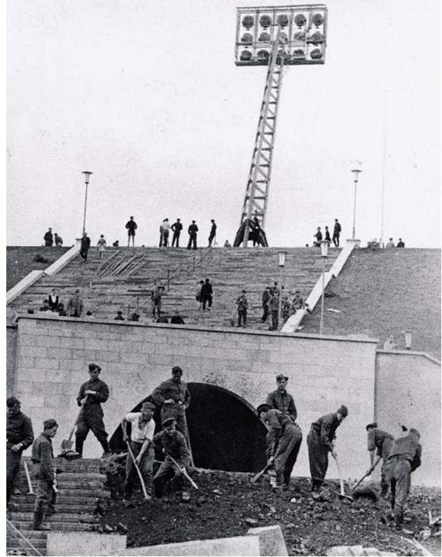
180.000 Helfer beteiligen sich am Bau
