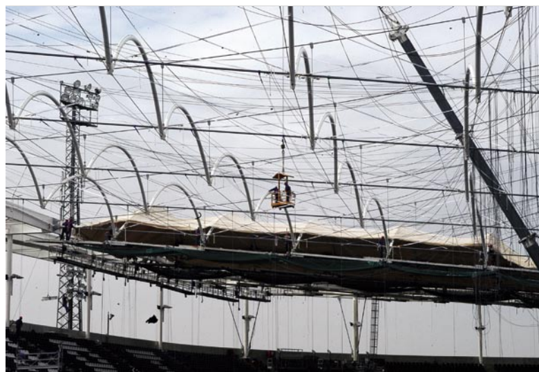
Montage der Dachbinder
