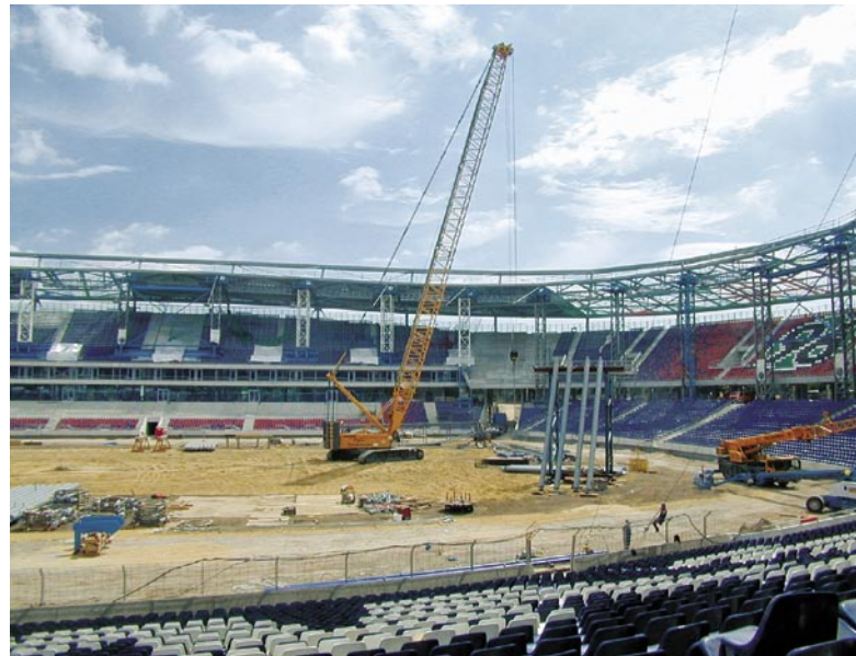
Montage von Dachteilen
