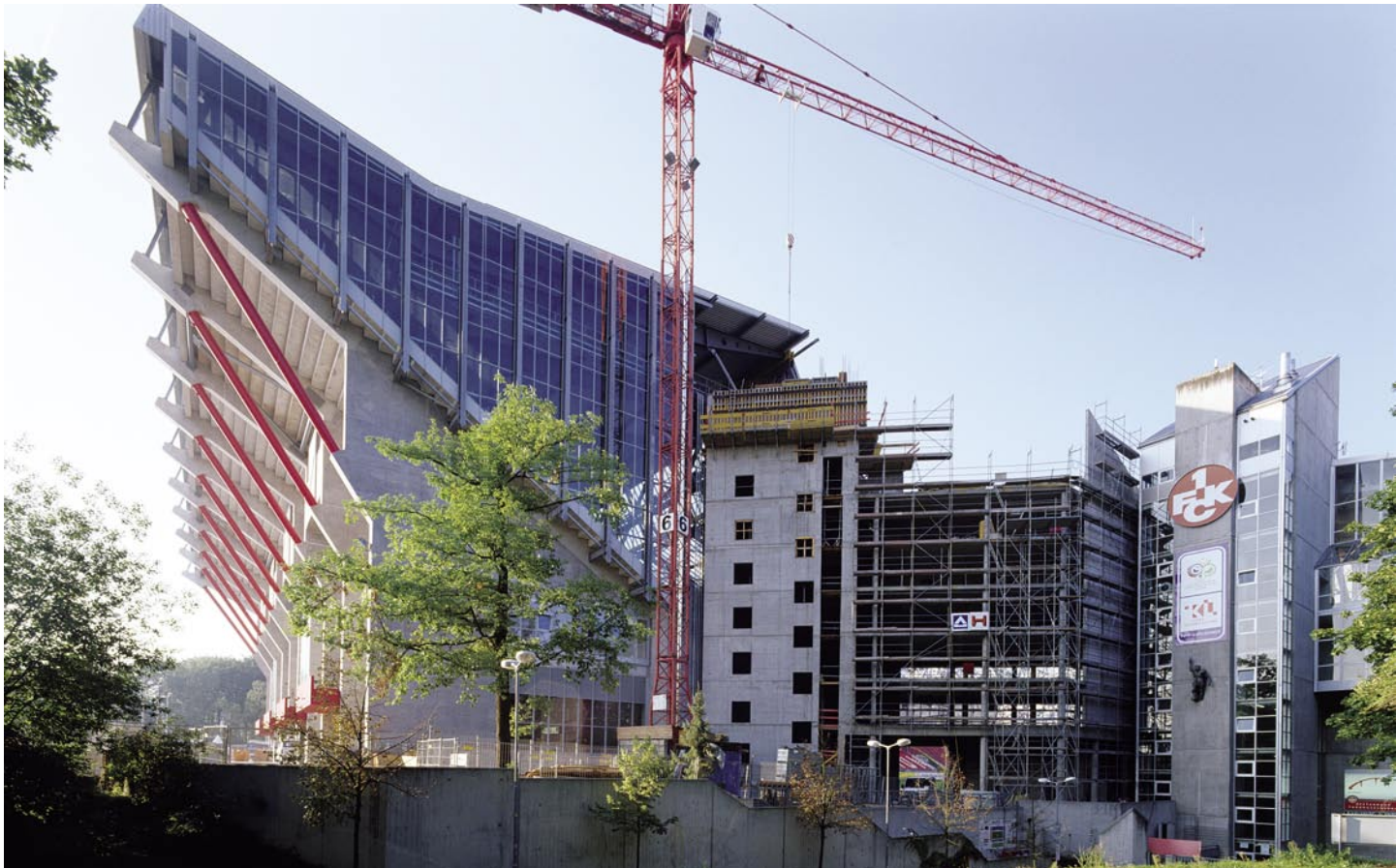
Drei Bauabschnitte auf einem Bild: Osttribüne, Baustelle des Logenturms und Treppenhaus der Nordtribüne
