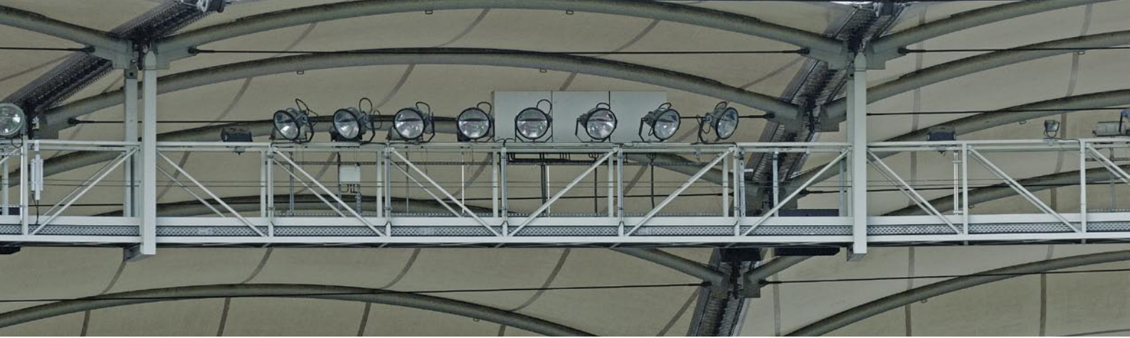
Service-Ring unter dem Dach
