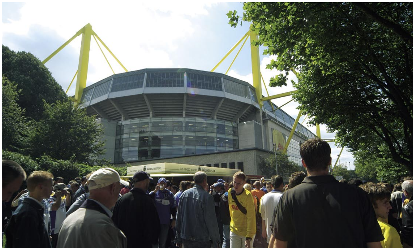
In der letzten Ausbaustufe wurden die Ecken geschlossen und als Tragwerk die gelben Pylone montiert
