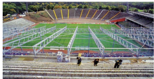
Temporäres Dach auf halber Höhe
