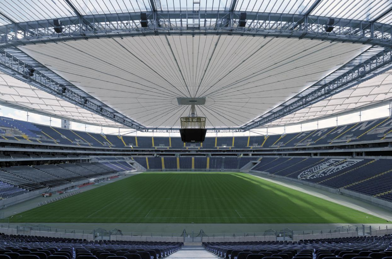
Statische Meisterleistung: das Dach des Frankfurter Stadions
