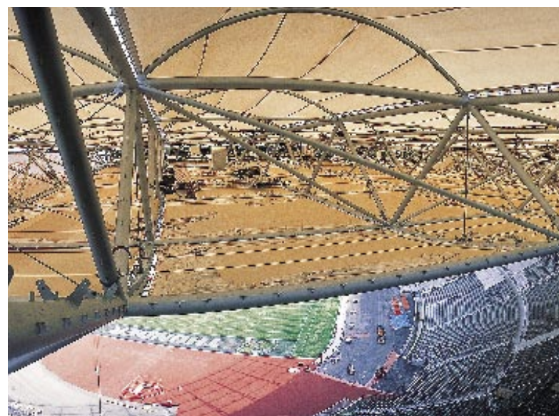
Blick zwischen die Dachmembranen
