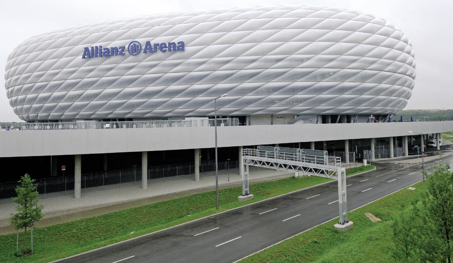
Die südliche, der Stadt zugewandte Seite. Die Allianz Arena verfügt über 11.000 PKW-Stellplätze, die ausschließlich über die Autobahn zu erreichen sind
