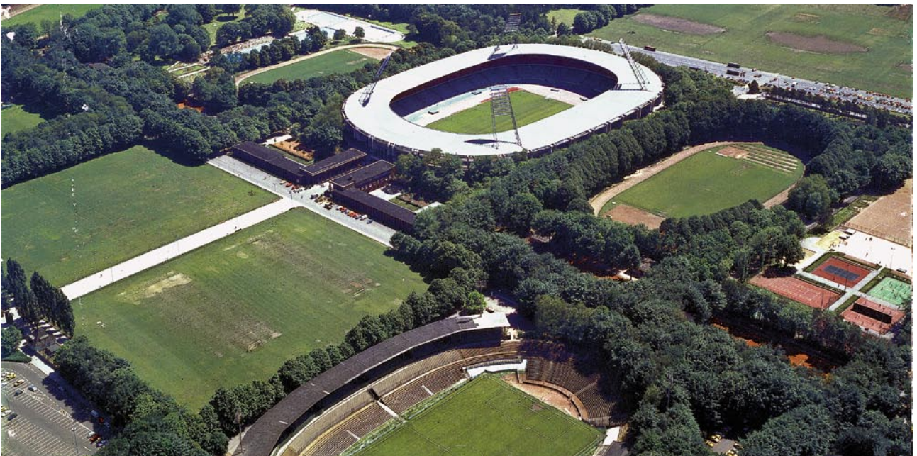
Das Müngersdorfer Stadion 1975 – während es gebaut wurde, spielte der 1. FC Köln in der Radrennbahn (Vordergrund)
