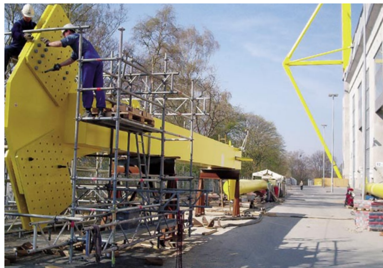
3. Ausbaustufe: Pylonmontage im Jahr 2003
