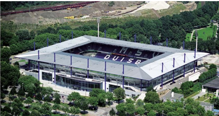
Die fertig gestellte MSV-Arena in Duisburg
