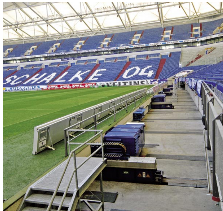
Im Süden kann die Rasenschublade ins Freie entweichen
