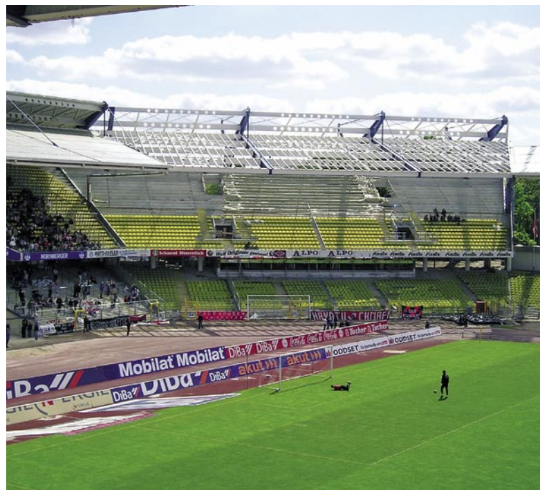
Umfangreichste Maßnahme: die Aufstockung der Tribünen
