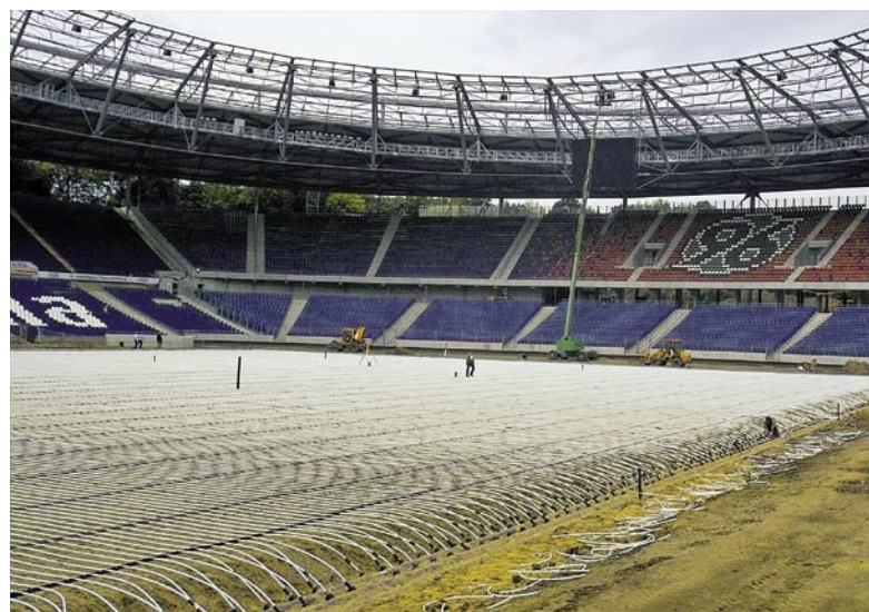
Einbau der Rasenheizung
