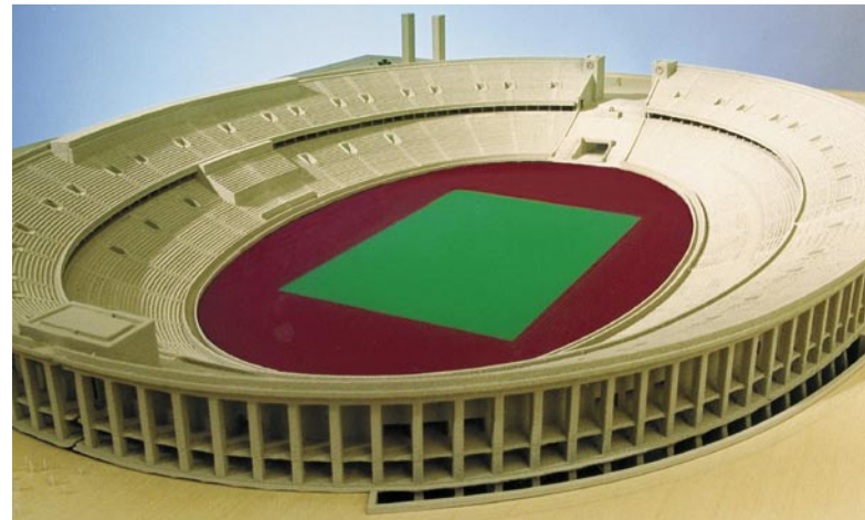
Nicht verwirklicht: Pläne für das Berliner Olympiastadion von Nedelykov, Granz und Moreira. Laufbahn und Spielfeld sollten auf Pontons in einem unterirdischen See schwimmen und für Fußballspiele abgesenkt werden können. Zusatztribünen über der Laufbahn hätten die Distanz zum Spielfeld verkürzt.
