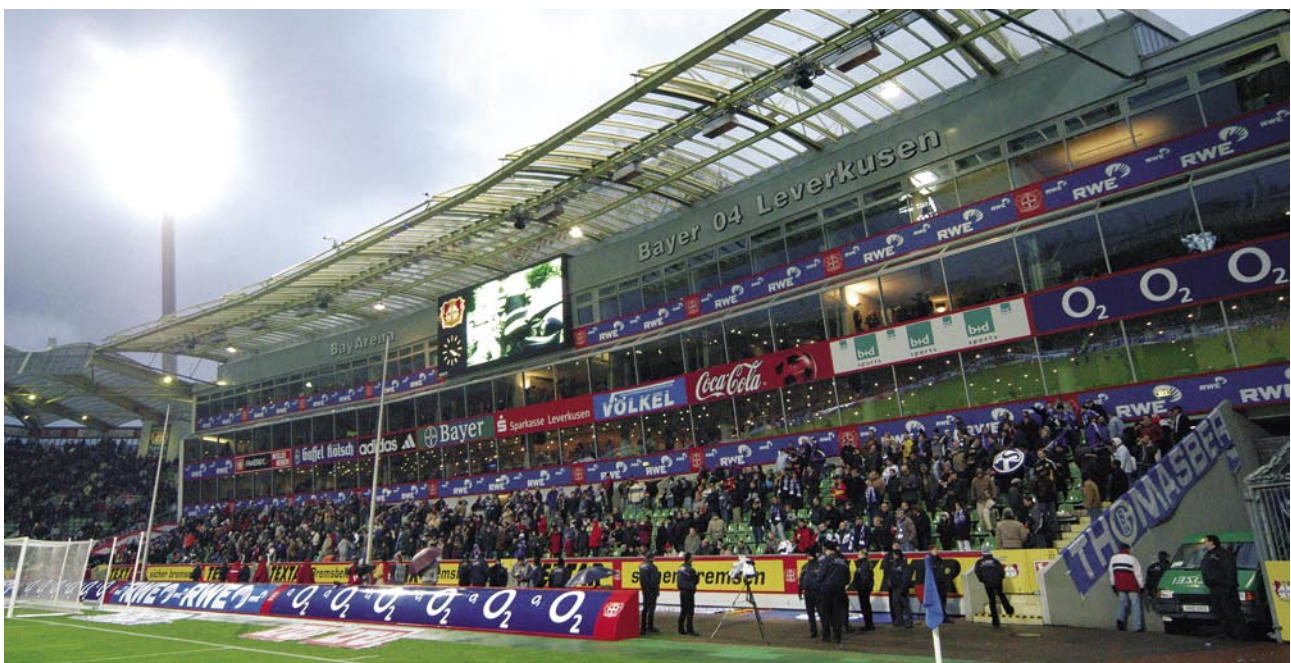
Das Logenkonzept der Leverkusener BayArena verbannt die VIPs hinter Glas
