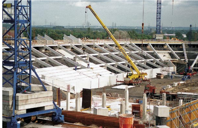
Fertigteilmontage
