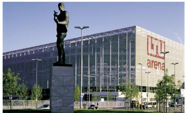
Die Fassade aus Aluminiumprofilen ist für Videoprojektionen geeignet
