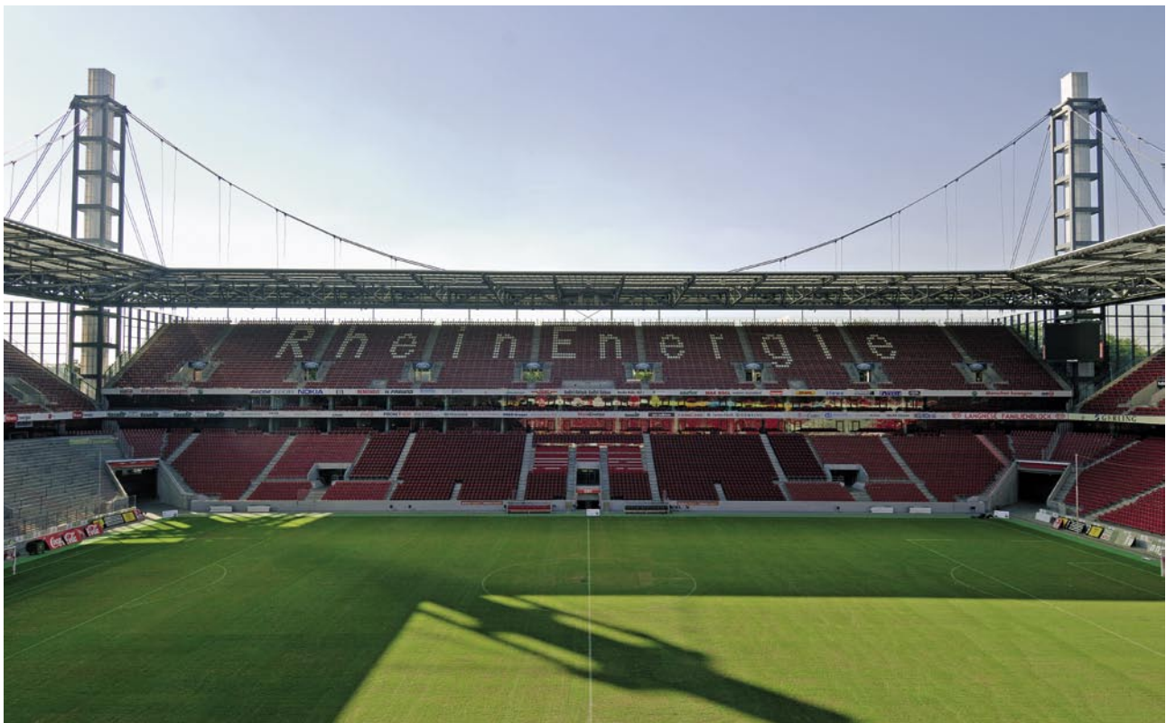
Frontalansicht der Westtribüne. Die Mundlöcher in den Ecken dienen z. B. bei Konzerten als Zufahrt für LKW – aber auch der Rasenbelüftung
