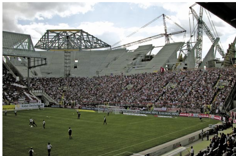
Fortschritt im Westen: die Arbeiten kommen voran
