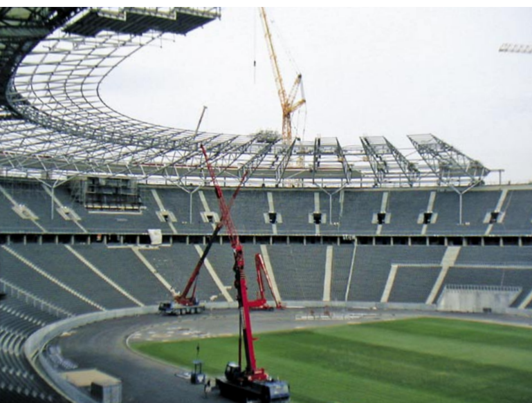
Baumträger stützen das Dach – einmalig in einem WM-Stadion
