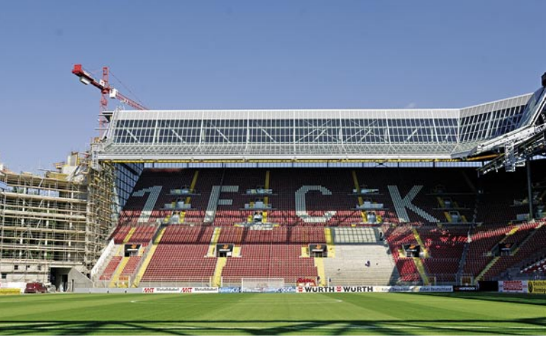
Osttribüne und Logenturm
