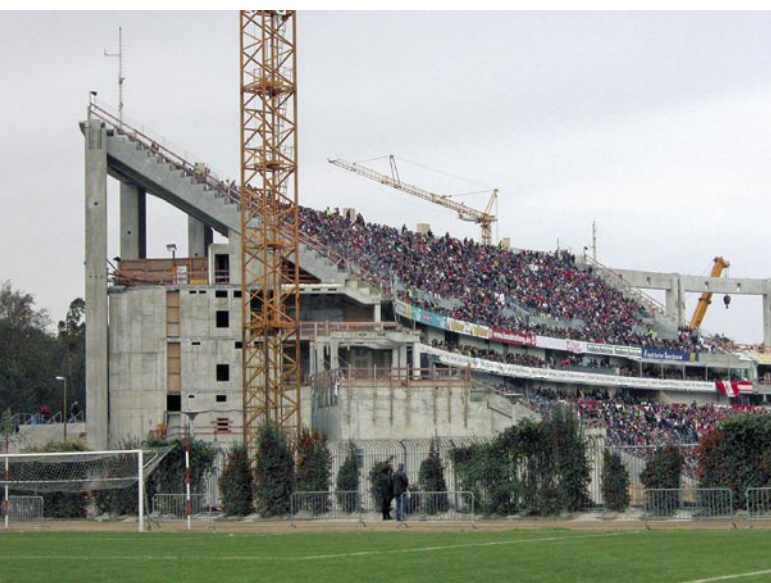
Umbau bei laufendem Spielbetrieb
