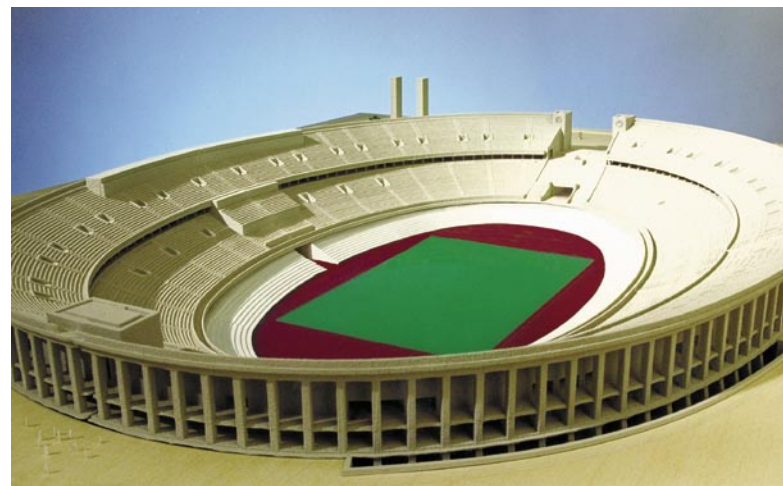
Nicht verwirklicht: Pläne für das Berliner Olympiastadion von Nedelykov, Granz und Moreira. Laufbahn und Spielfeld sollten auf Pontons in einem unterirdischen See schwimmen und für Fußballspiele abgesenkt werden können. Zusatztribünen über der Laufbahn hätten die Distanz zum Spielfeld verkürzt.
