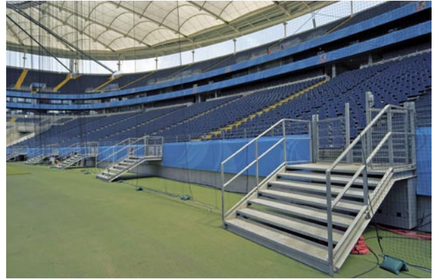
Treppen überbrücken den Höhenunterschied zum Innenraum
