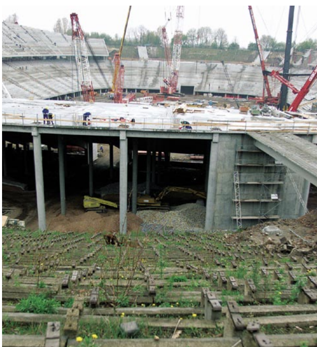
Das Stadion steht auf 720 Rammpfählen
