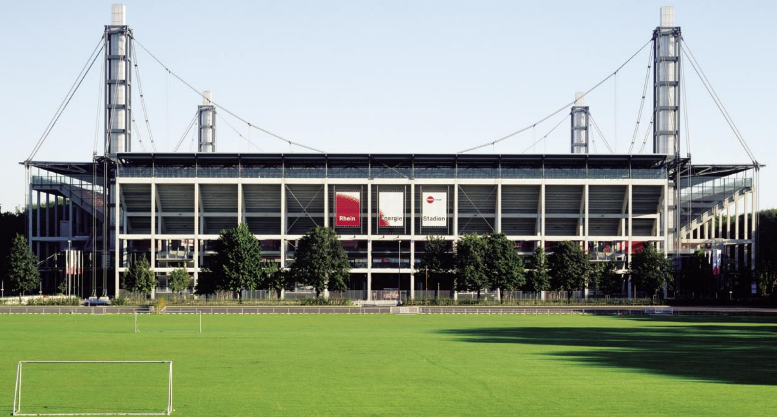
Blick vom Süden auf das Stadion. An den hoch aufragenden, abends beleuchtenden Türmen ist das Dach nach dem Prinzip der Hängebrücke befestigt
