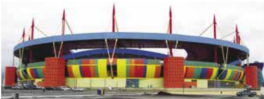
Der Zugang erfolgt über die außen liegenden Treppenhäuser
