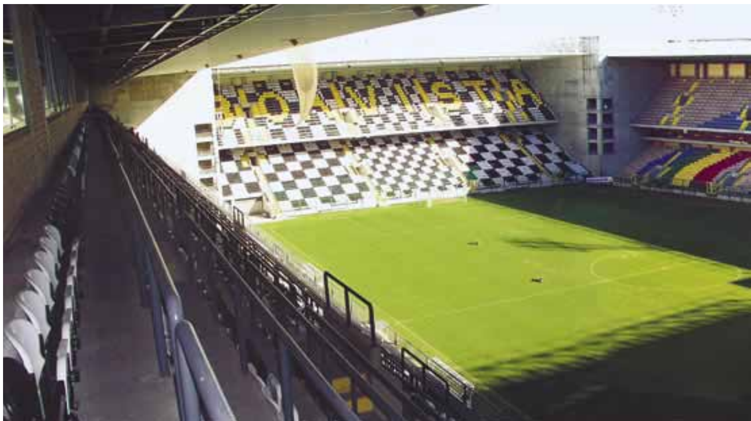
Tribüne für Tribüne wurde das Stadion bei laufendem Betrieb umgebaut
