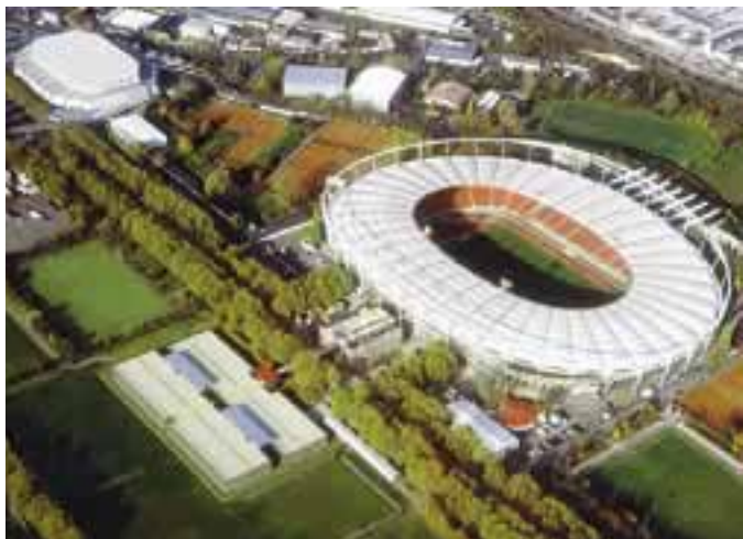
Unmittelbar nebeneinander: Das Gottlieb-Daimler-Stadion und die Schleyer-Halle. Auf dem Gelände dazwischen wird die neue Arena gebaut Foto: Arat, Siegel & Partner
