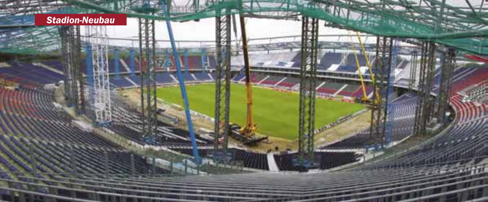
Die AWDarena mitten im Umbau
