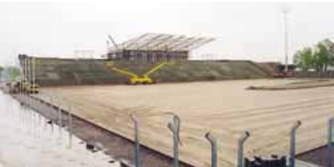
Das neue Stadion drei Monate vor der Fertigstellung Foto: Stadionwelt
