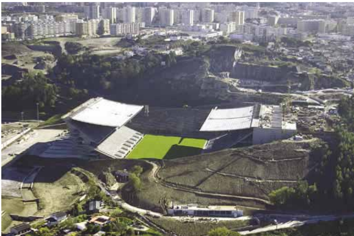
Eingebettet in das Felsmassiv des Monte Castro Foto: Euro 2004, S.A.
