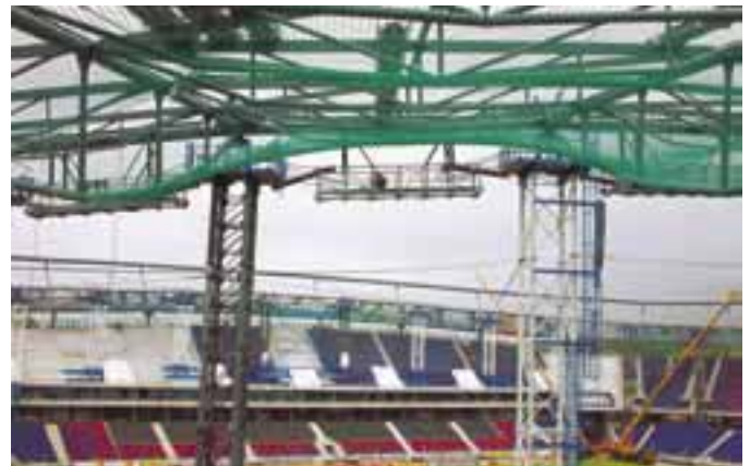
Intensive Arbeiten am Arena-Dach
