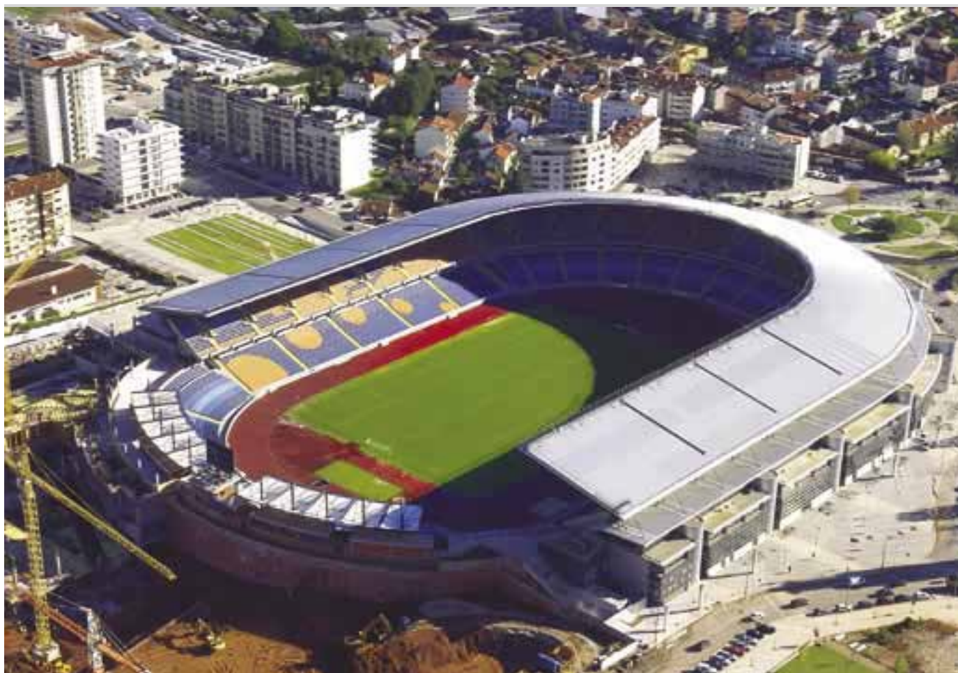
Das U-förmige Dach bedeckt drei Viertel der Tribünen
