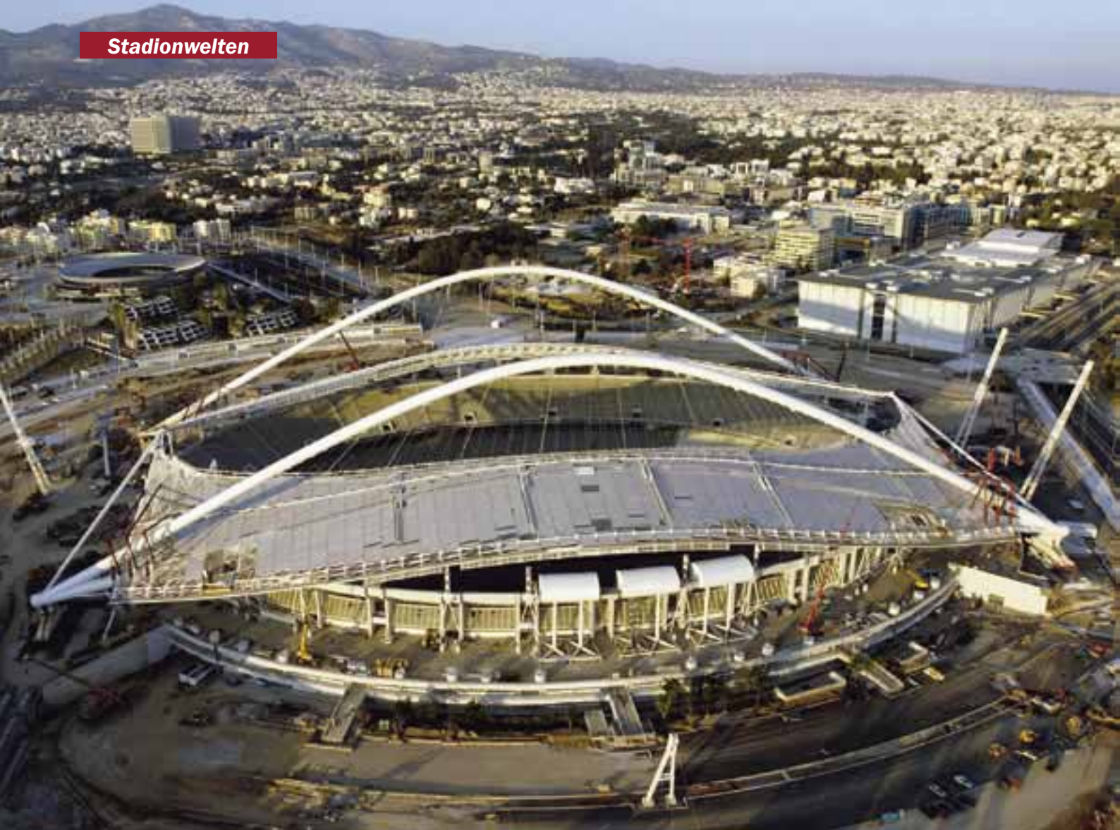
Das Prunkstück der Spiele: Das Athener Olympiastadion mit der futuristischen Dachkonstruktion von Santiago Calatrava
