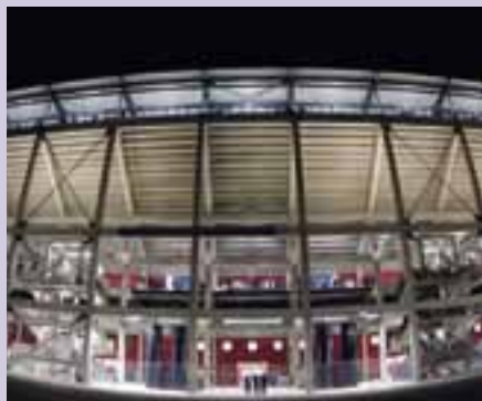
Die Rückseite der Südtribüne
