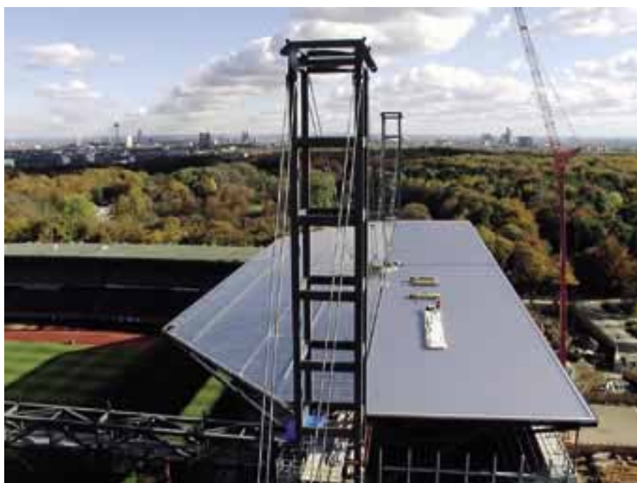
Die Tragwerk-Konstruktion entspricht der einer Hängebrücke Foto: Stadionwelt
