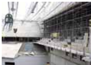
Das Richtfest wurde bereits gefeiert
