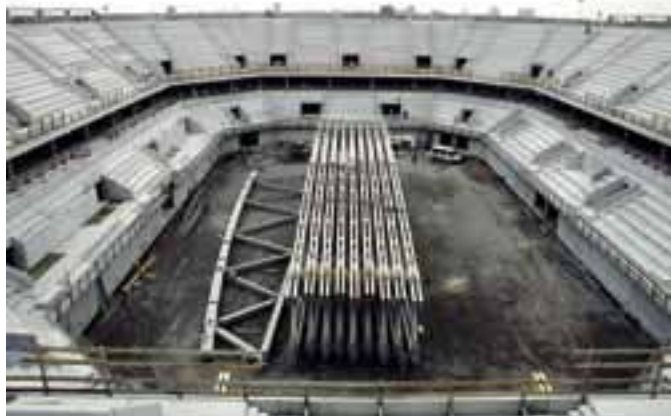
Mit Spezialkränen werden die Binder angehoben.
