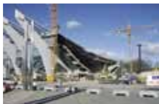
Teile der alten Halle wurden abgerissen
