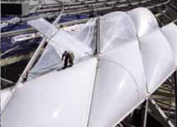
Montage in mehr als 50 Metern Höhe, die Dacharbeiten an der Allianz Arena
