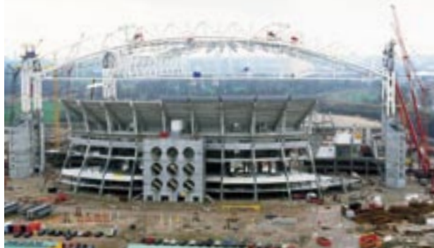
Die Baustelle: Das Dach wird montiert, während der Massivbau noch wächst
