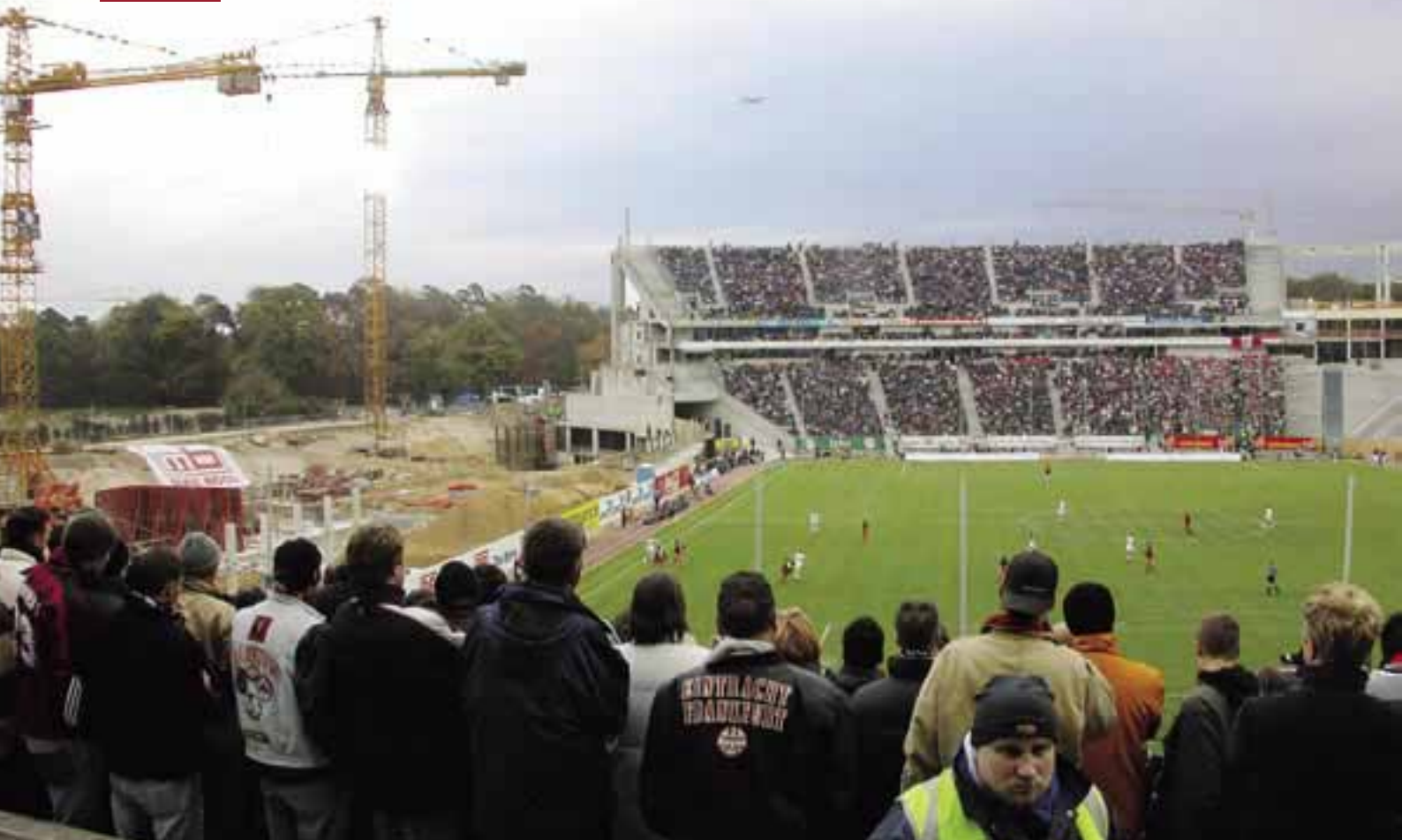
Bundesliga-Fußball auf der Baustelle: Das neue Waldstadion in Frankfurt
