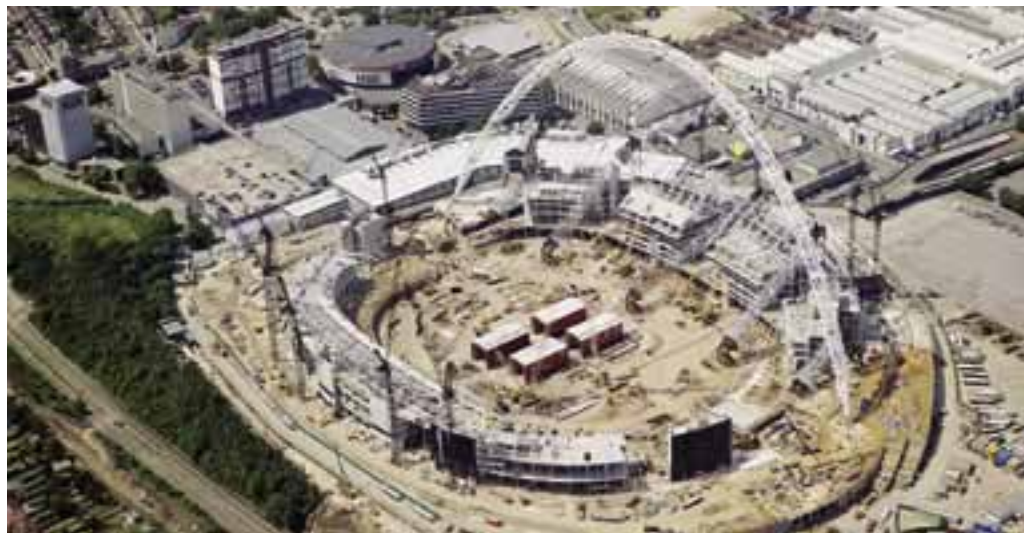
Bereits zwei Jahre vor der Fertigstellung ein imposanter Anblick
