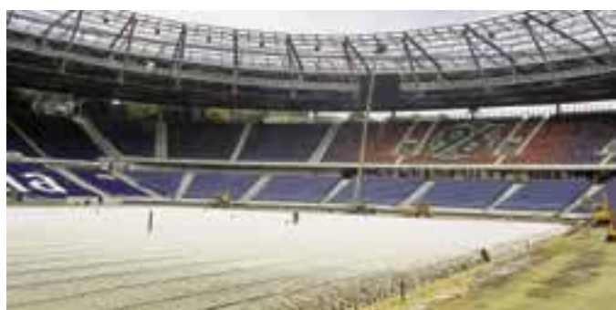
Eine neue Rasenheizung für die AWDarena
