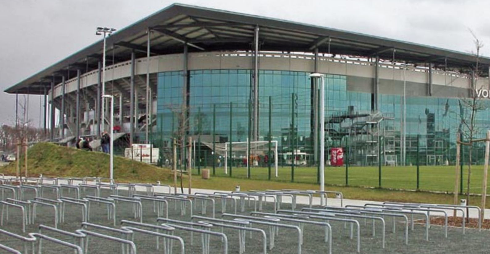
Die gläserne Fassade der Haupttribüne (davor der Trainingsplatz mit „Tribüne“) korrespondiert mit der VW-Autostadt gegenüber.
