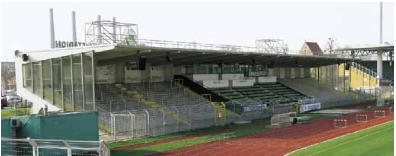
Denkmalgeschützte Tribüne von 1961
