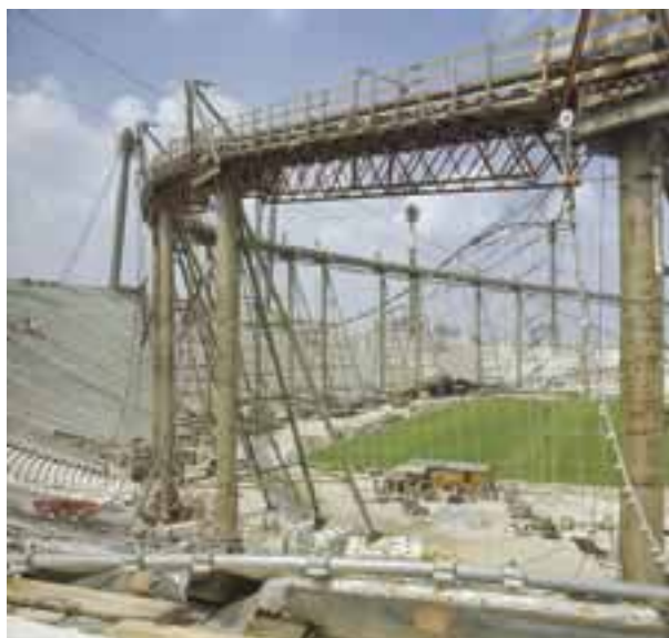
Hilfskonstruktion für die Dachmontage
