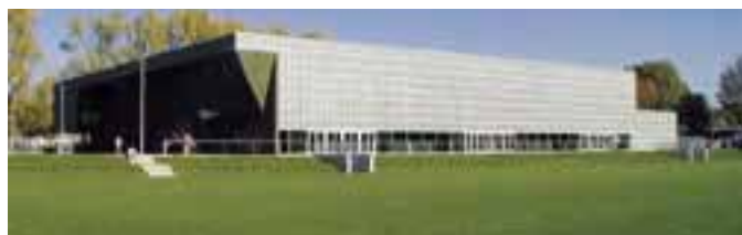
Solar- und Kletterwand
