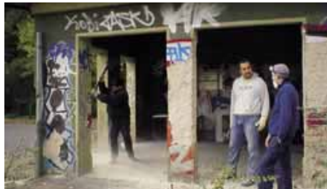
Schweiß und Baustaub
