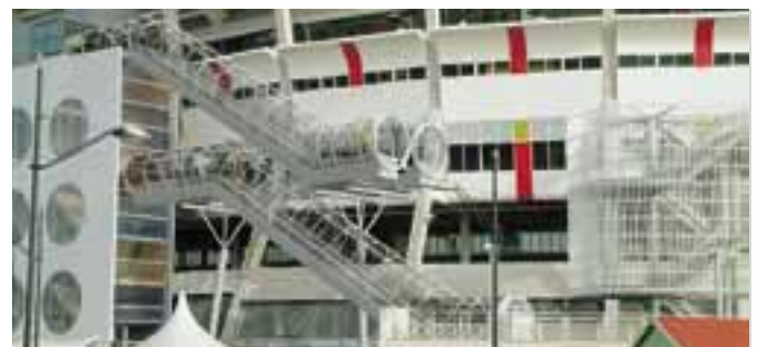
Zusätzliche Rolltreppen für die Arena
