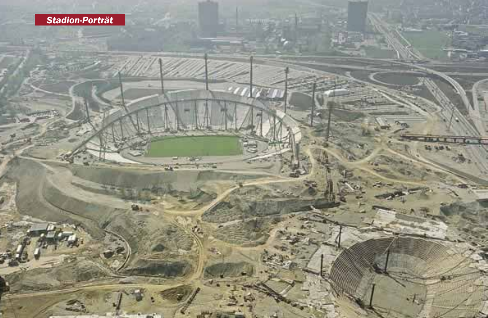
Blick vom Fernsehturm auf die Münchener Baustelle ...
