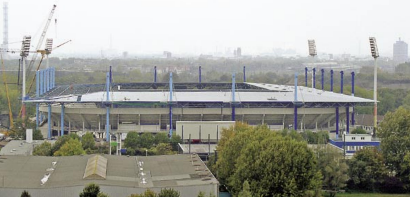
Die MSV-Arena ein Jahr nach der Grundsteinlegung
