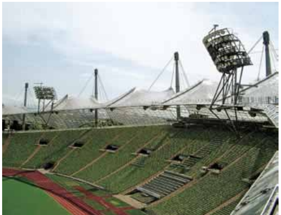
Die Dachkonstruktion: Eine Pionierleistung der Ingenieure
