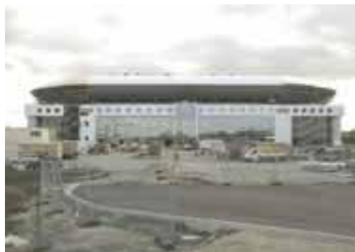
Die Außenfassade ist bereits fertig
