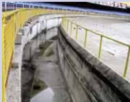
Einer der Gräben
