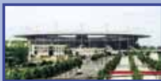
Stade de France (Nationalstadion) Saint-Denis
