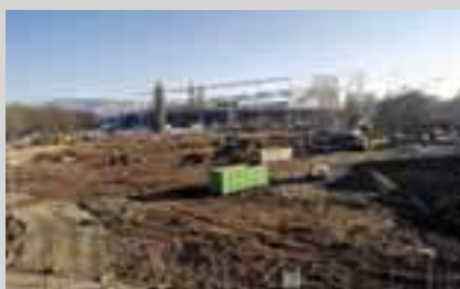
Baufeld „Neue Arena“ zwischen Stadion und Halle
