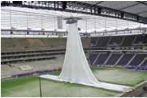
Montage des Faltdaches
