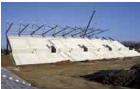
Rohbau der ersten Tribüne
