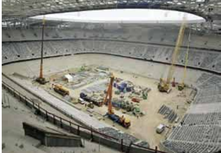
Blick auf die Baustelle in Fröttmaning
