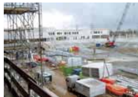
Im Bau: Euroborg in Groningen
