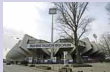
An der Castroper Straße
