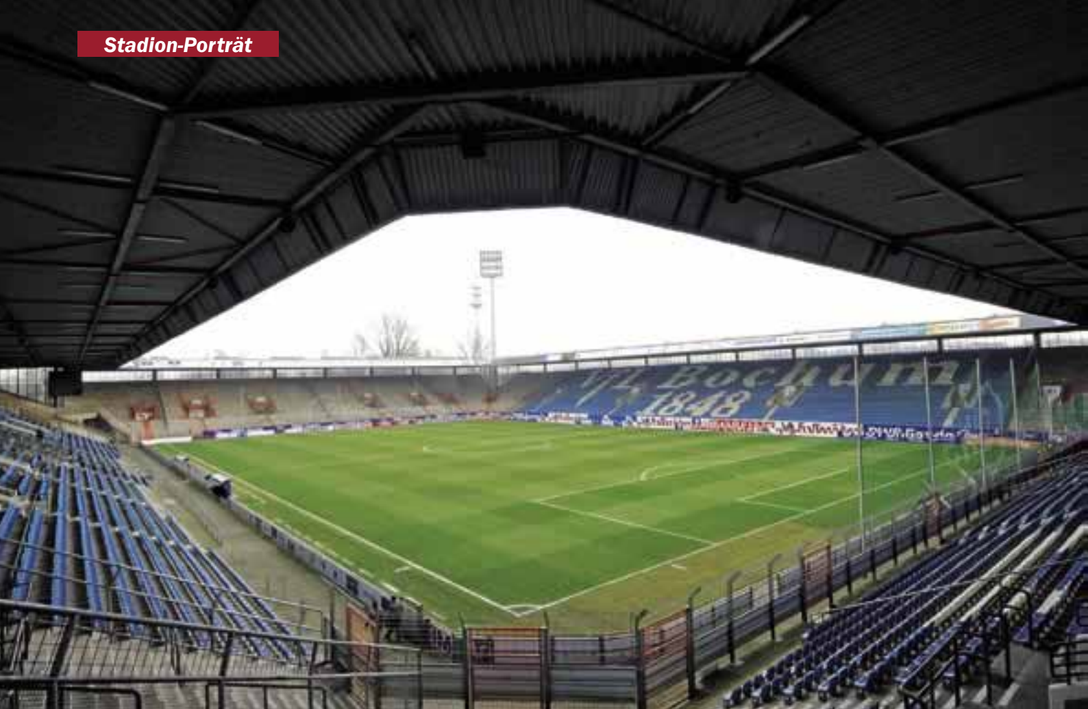
Blick aus der Ecke Nord/West ins Ruhrstadion
