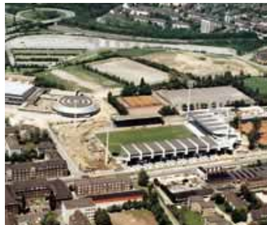
Während des Umbaus 1977
