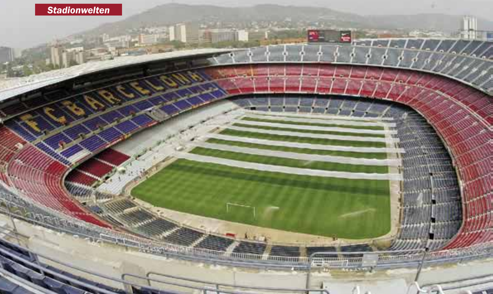
Erneuerung der Haupttribüne im Camp Nou in Barcelona (Sommer 2004)
