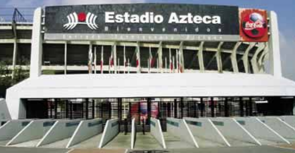
Modernisierter Bereich am Stadionportal
