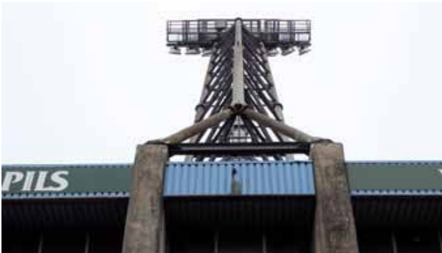
Kaiserlautern, Fritz-Walter-Stadion vor dem Umbau
