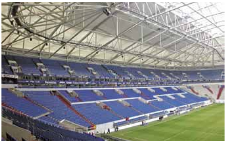
Haupttribüne – die vorgelagerten Sitzreihen wurden nachträglich installiert.
