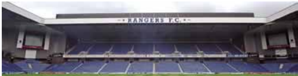
Videowände statt Eckausbau Foto: Stadionwelt
