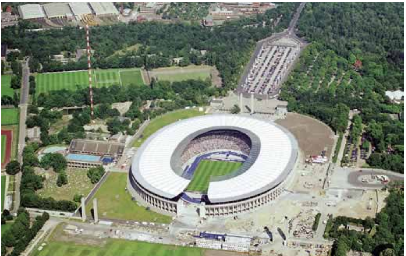
Das Endspielstadion ist fertig, einige Infrastrukturprojekte stehen noch aus.
