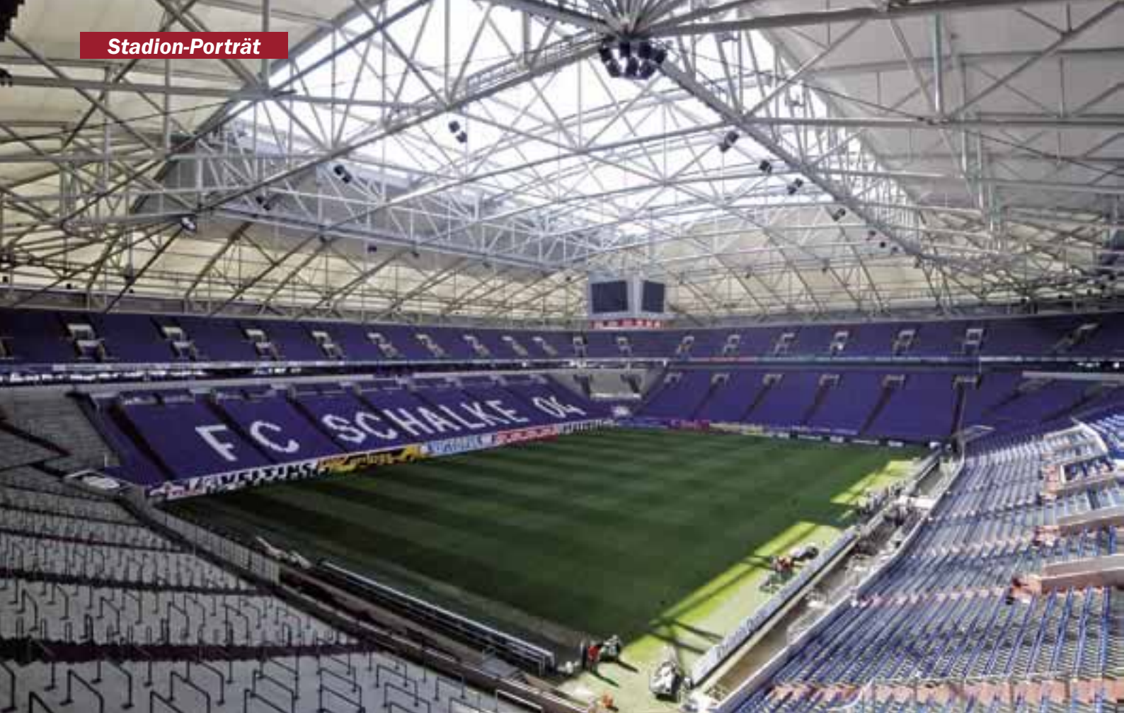
Blick über die Stehänge der Nordkurve in die Arena. Gegenüber kann die Rasenwanne herausgefahren werden.
