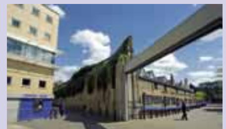
Die alte Rückwand des „Shed“
