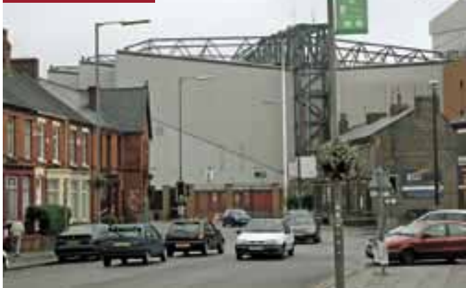
Unmittelbar hinter dem Kop beginnt das Wohngebiet.
