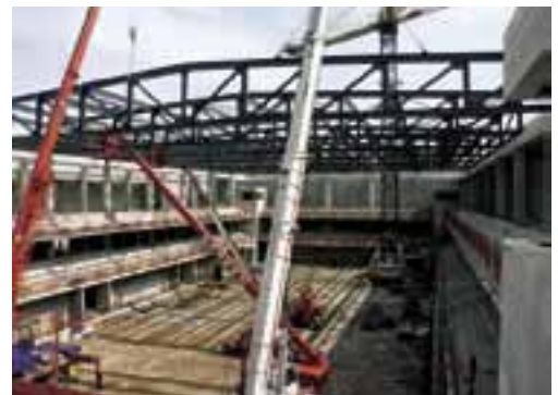
Montage der Dachbinder
