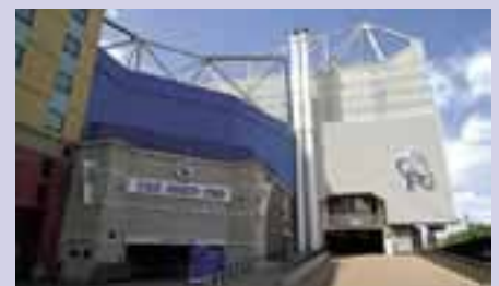
Hinter der Ost verläuft eine Bahntrasse
