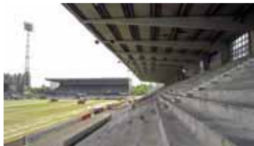
Arbeiten während der Sommerpause
