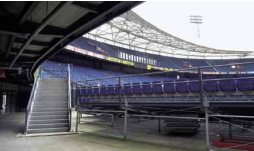
Stahlrohr als Grundmaterial für Zusatztribünen und Dach
