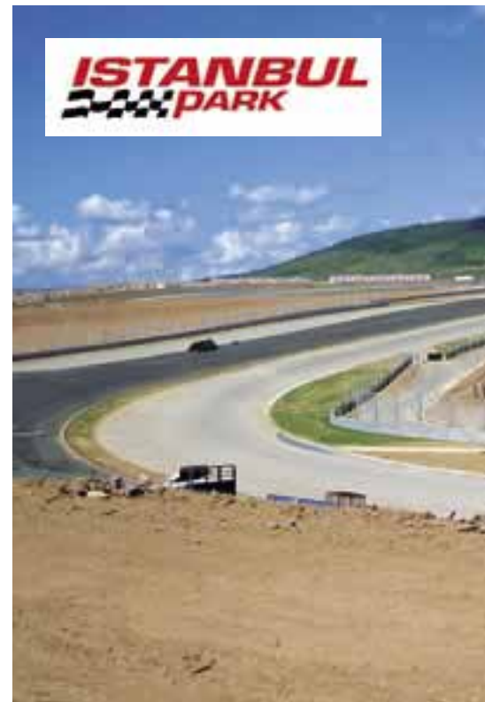
Die Bauarbeiten an der Rennstrecke dauern noch an.
