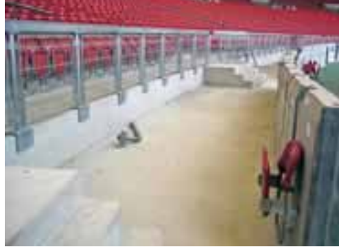
Ein Graben für mehr Sicherheit
