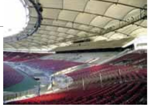
Der Rohbau der neuen Gegengerade
