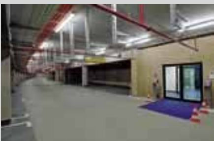
In der Tiefgarage
