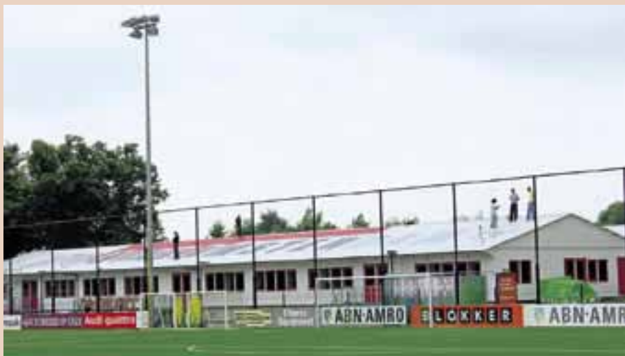
Das frisch restaurierte Supporters Home erhält seinen Dachanstrich.
