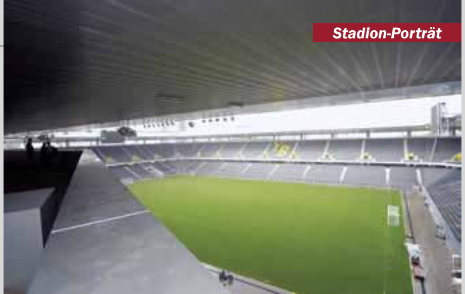
Das Logendach, Raum für zusätzliche Fernsehstudios während der EM 2008
