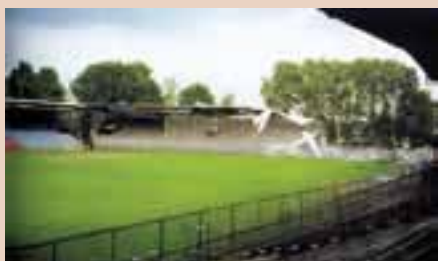
Abriss des alten Stadions „De Meer“
