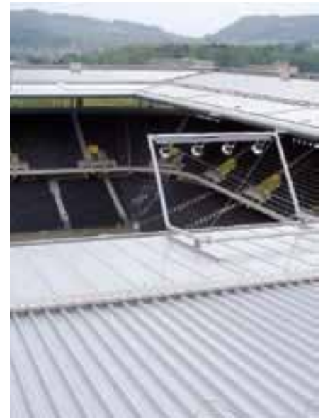
Blick von der Plattform über das Stadionsdach
