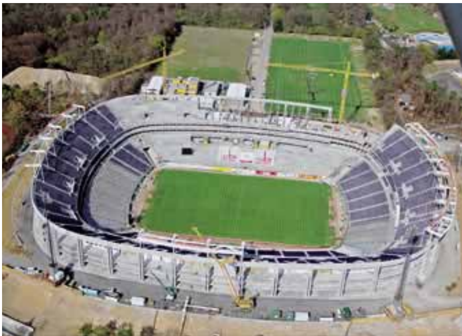
Der Umbau erfolgte bei laufendem Spielbetrieb.
