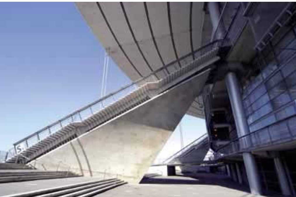
Einem Schiffsbug nachempfundene Treppen auf die Verteilerebene
