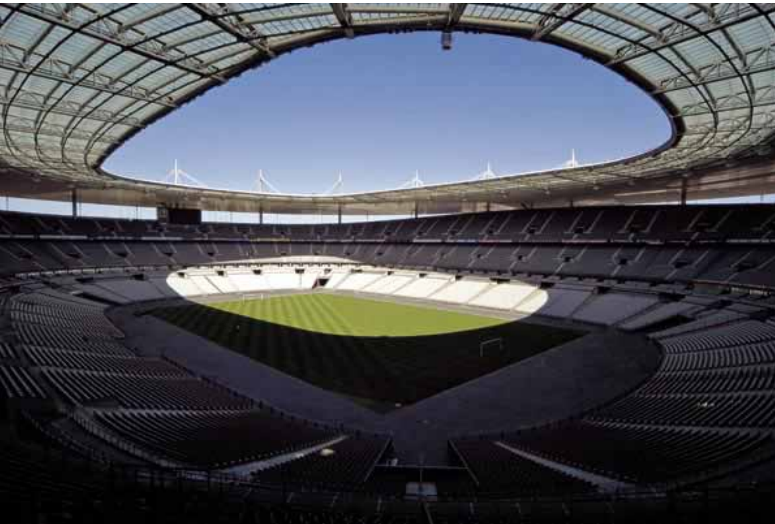
Der Unterrang besteht aus Teleskoptribünen, die zurückgezogen werden können und so die Laufbahn freigeben – oder Platz für Events aller Art schaffen
