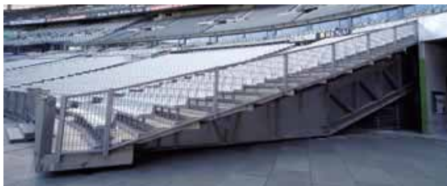
Eine Stahlverbundkonstruktion; das Plateau oben verschwindet per Hydraulik im Boden
