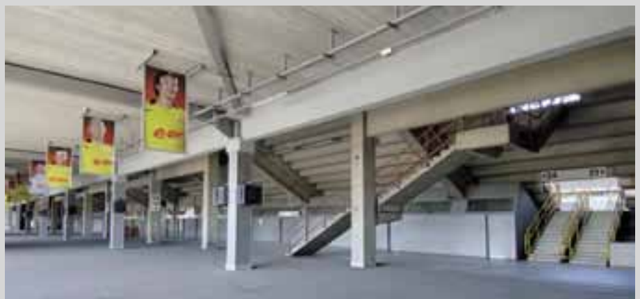
Sichtbeton und freiliegender Kabelwege - um so plakativer wirken die Botschaften der Sponsoren
