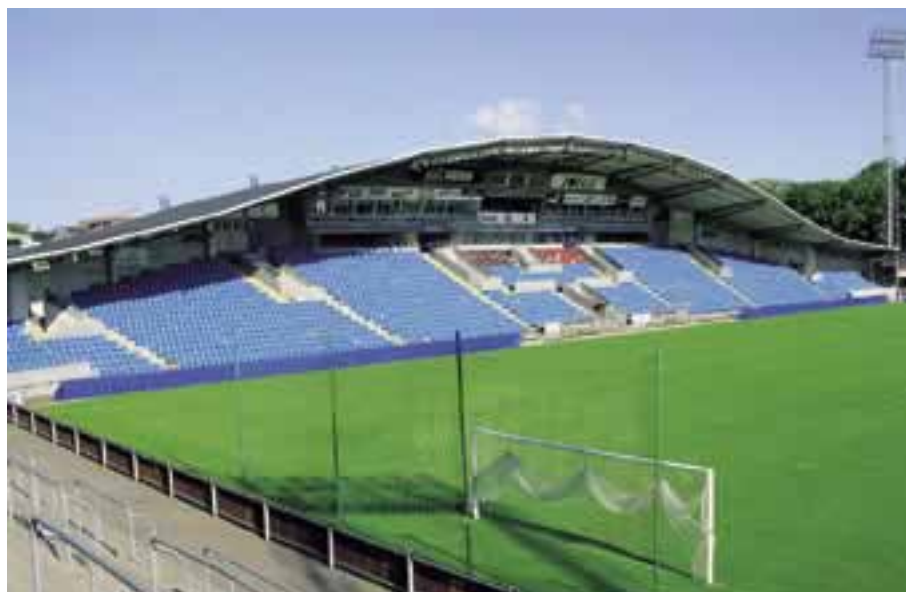
Die geschwungene Tribünenkonstruktion des Nya Ullevi
