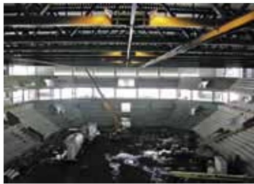
Der Rohbau ist abgeschlossen, der Innenausbau beginnt.
