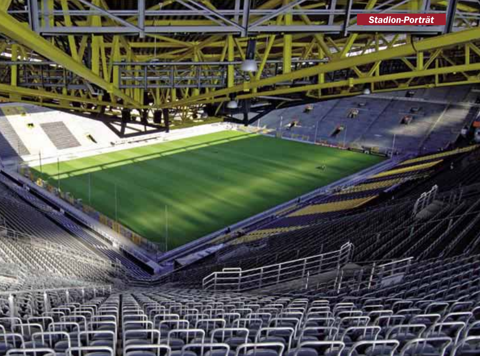
Der Eckausbau unter Bewahrung freier Sichtlinien auf das Spielfeld bedeutete eine besondere ingenieurtechnische Herausforderung
