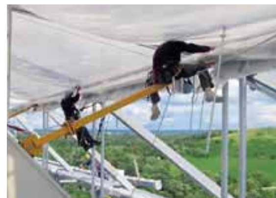
Industriekletterer im Einsatz Fotos: membranteam.de
