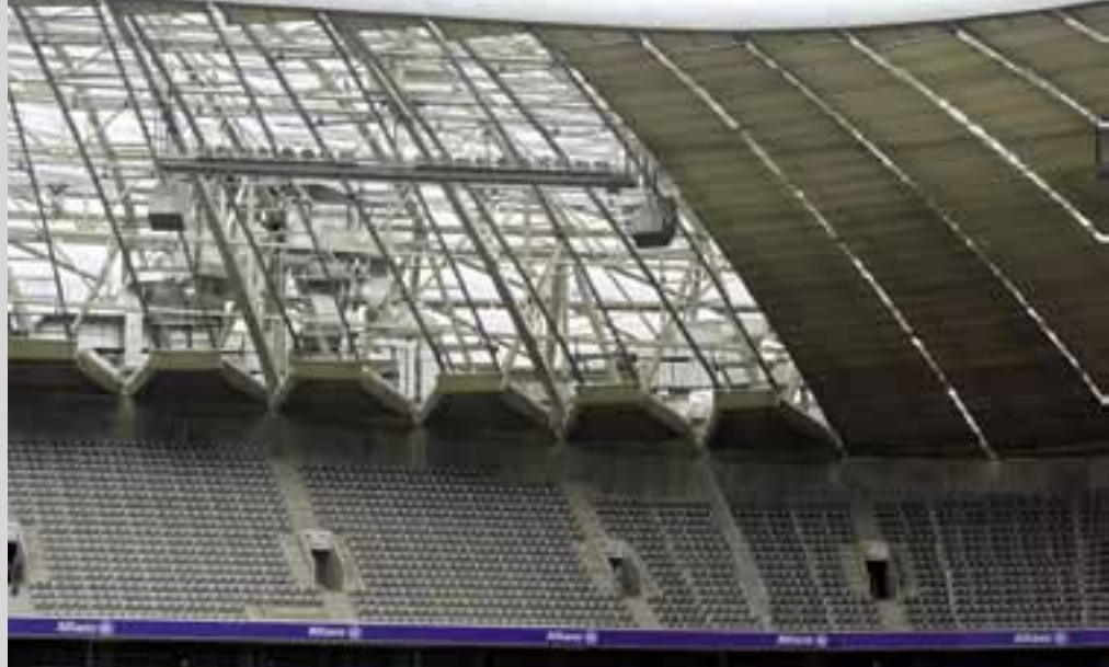
Verschiebbare Lamellen für mehr Sonnenlicht an spielfreien Tagen
