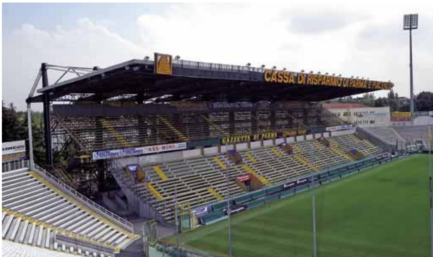
Gegentribüne: den Oberrang bildet eine Stahlrohrkonstruktion
