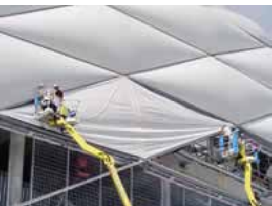
Einziehen eines Fassadenkissens
