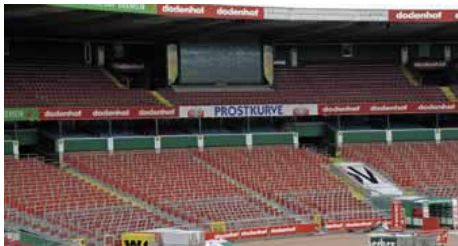
Werder Bremen: Weserstadion, Ostkurve (Blöcke 54 – 64)
