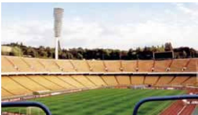
NSK Olimpijskyj: Kein Dach, aber imposantes Flutlicht
