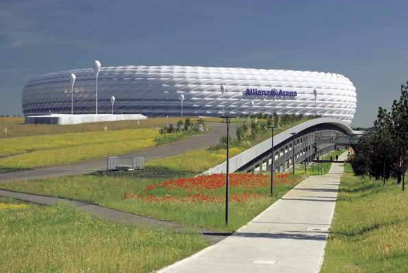
Die Parkdecks im Inneren der Esplanade sind ebenso geschwungen wie ihre Oberfläche
