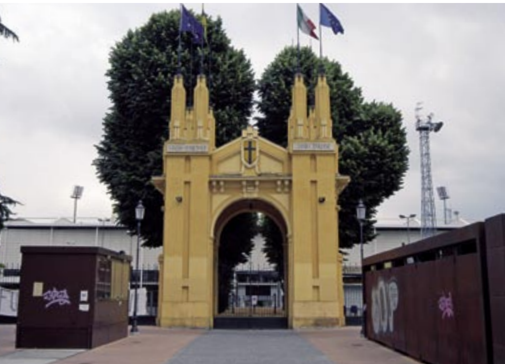
Das ursprüngliche Portal blieb erhalten
