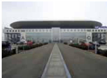
Vom Parkplatz in die Arena
