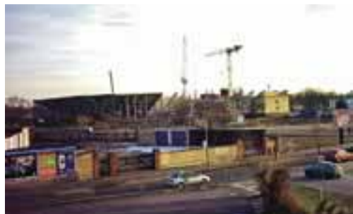
Die Stadionbaustelle, von der Bördelandhalle aus betrachtet
