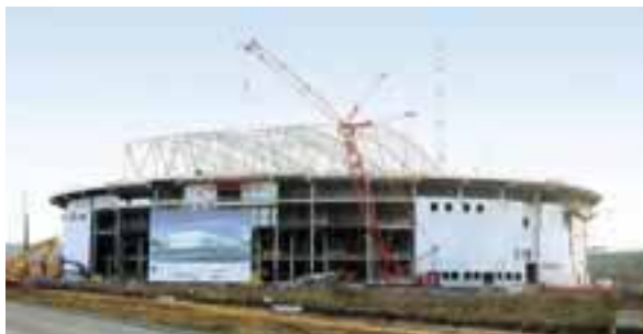
Montage der Dachhauptträger im Dezember Foto: DüsseldorfCongress
