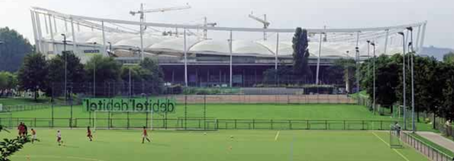
Die Eleganz der Dachkonstruktion erschließt sich erst aus einiger Entfernung.
