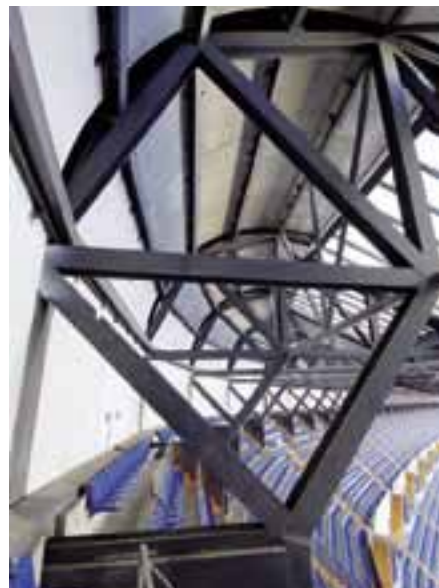
Dachtragwerk über dem steilen Oberrang
