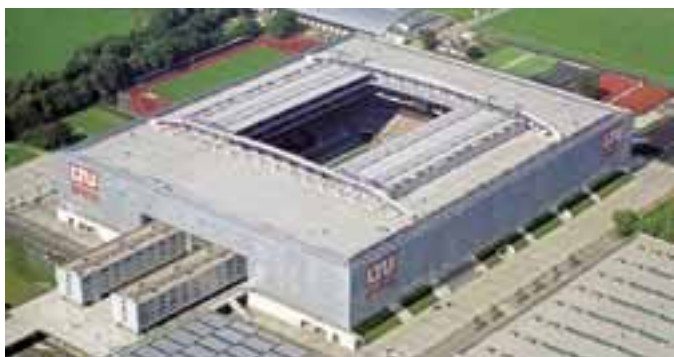
Die LTU arena aus der Luft
