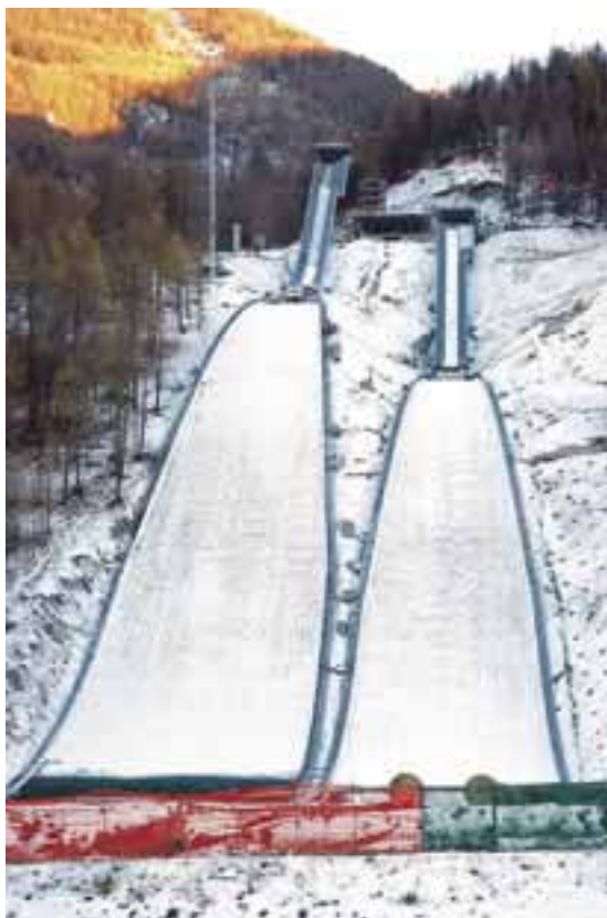
Skisprunganlage in Pragelato
