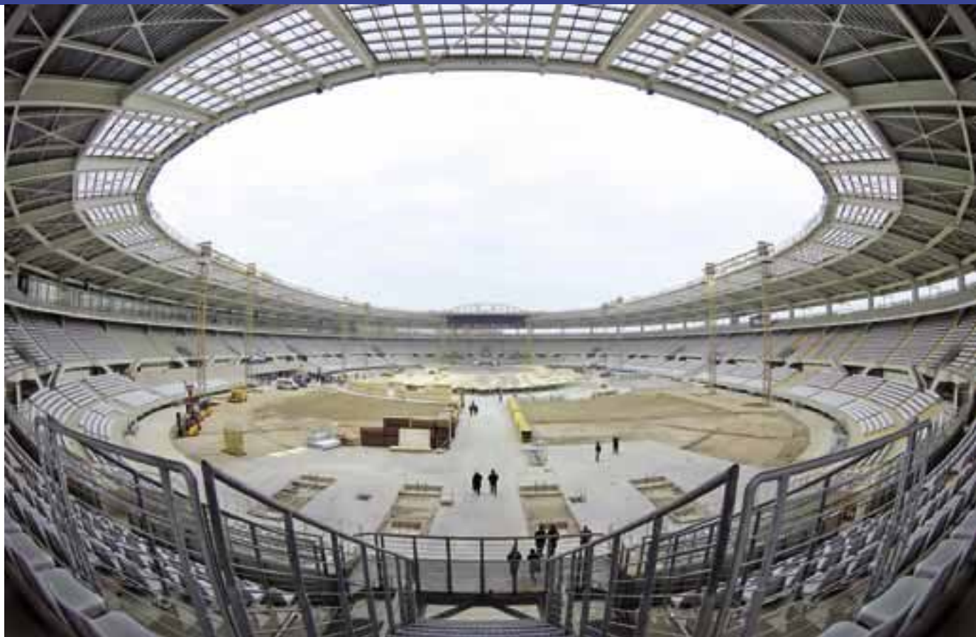
Bauarbeiten am Stadio Olimpico: Hier finden die Eröffnungs- und Abschlussfeierlichkeiten statt
