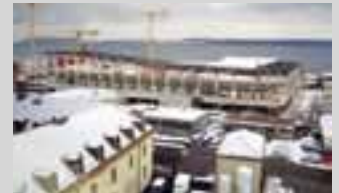
Stadionbaustelle Foto: Markus Stüdel
