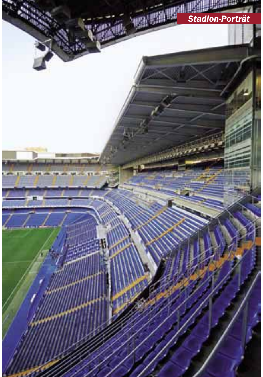
Die Haupttribüne wurde vor zwei Jahren fertig gestellt
