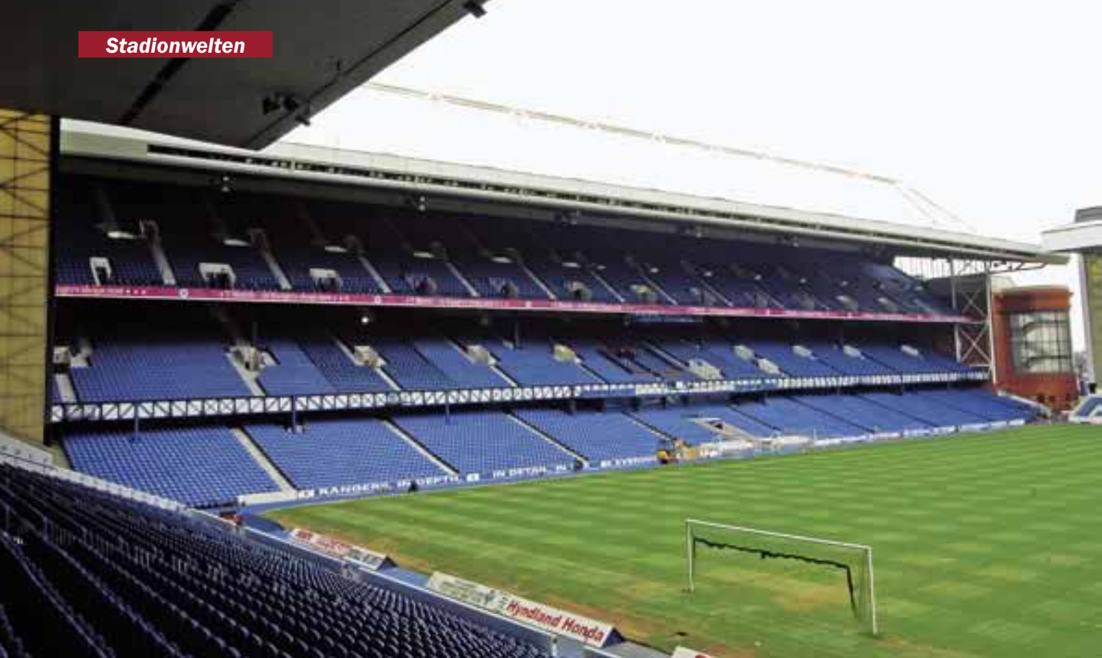
Ein Leitch-Klassiker: Sein Mainstand im Ibrox Park von 1929 wurde später auf drei Ränge aufgestockt.
