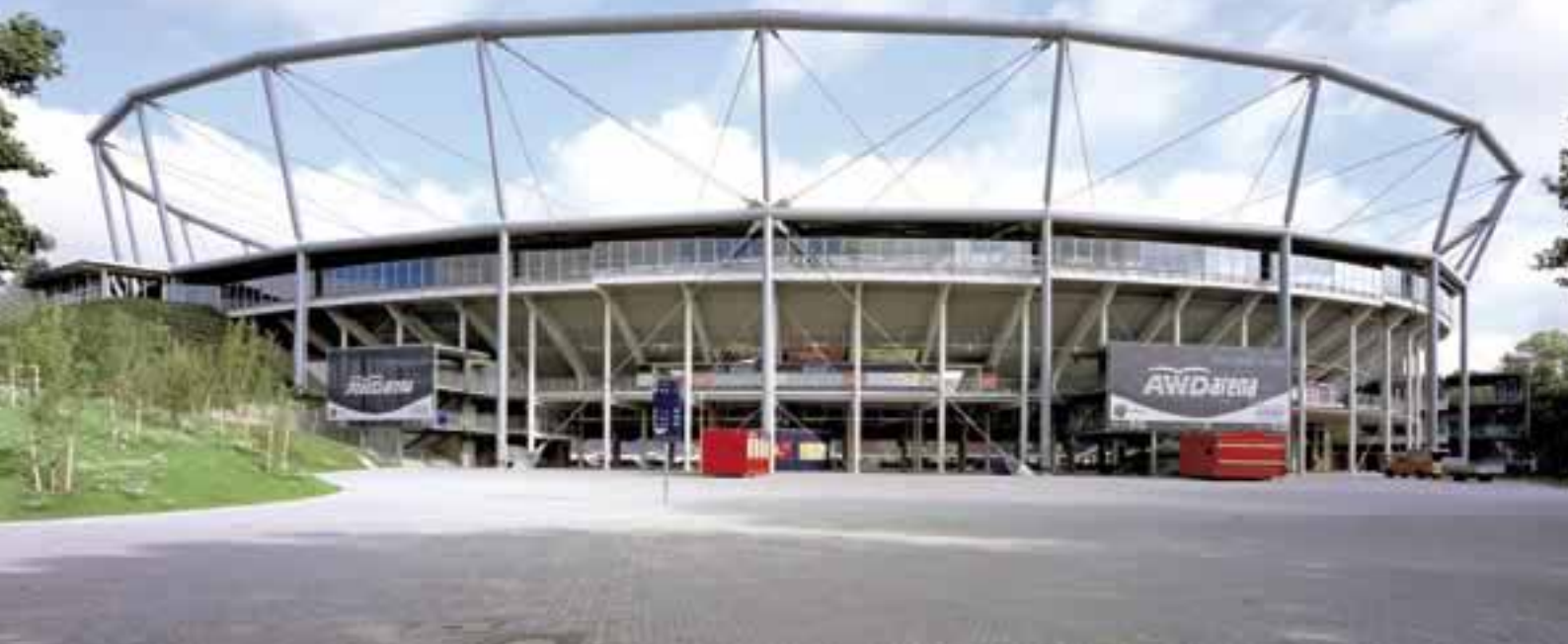
Im Süden der AWD-Arena. Ins Auge springt vor allem das Kräftespiel der Dachkonstruktion.
