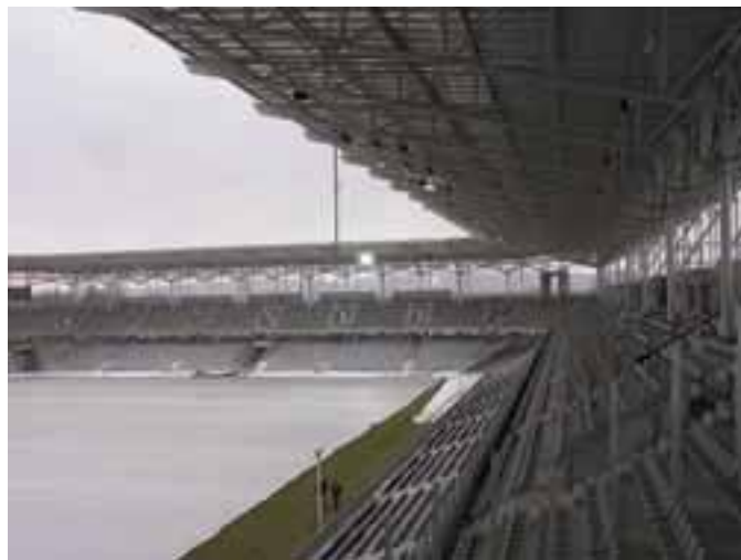
Die letzten Vorbereitungen im neuen Stadion in Kielce Foto: stadionkorony.prv.pl
