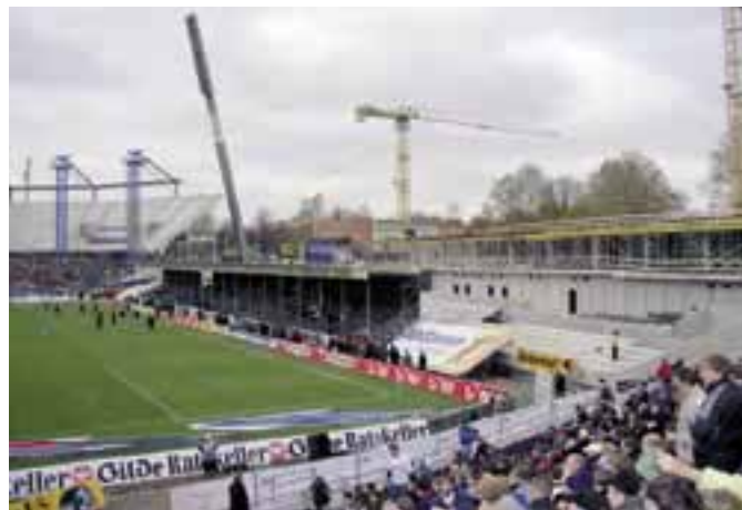
Die provisorische VIP-Tribüne wurde mehrfach auf- und abgebaut. Foto: Stadionwelt
