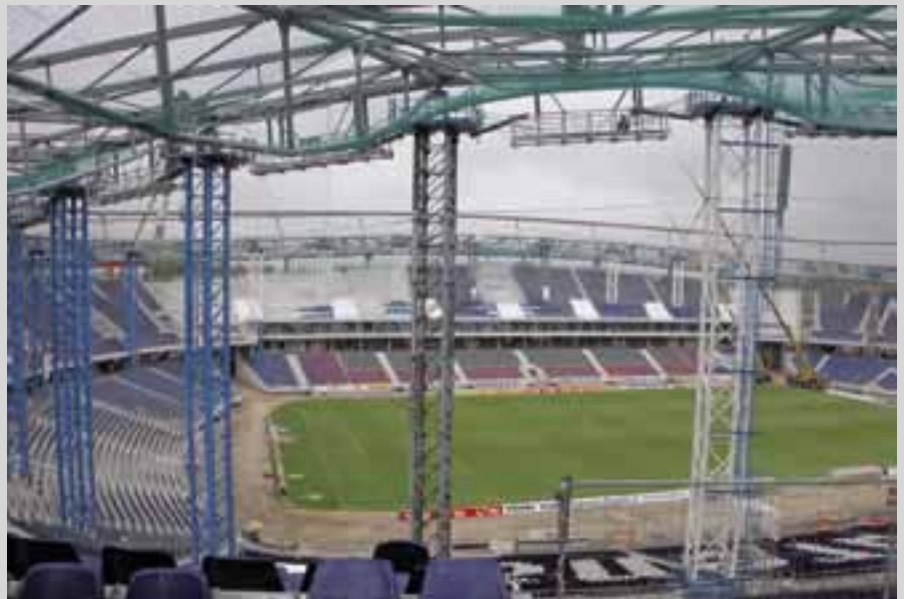
Die komplexe Dachkonstruktion zwang zur Improvisation.
