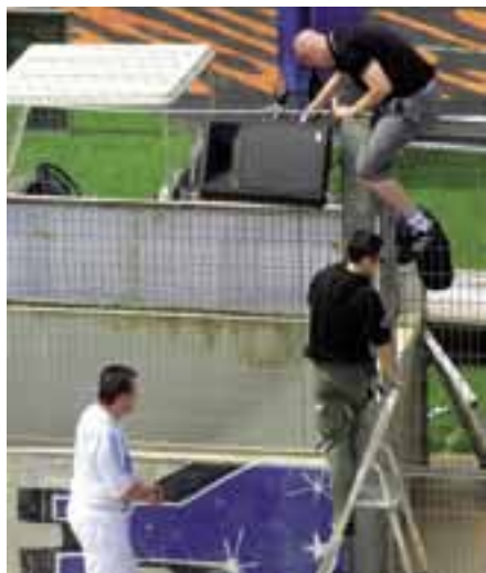
Anlagenaufbau beim CU'84 Foto: Stadionwelt
