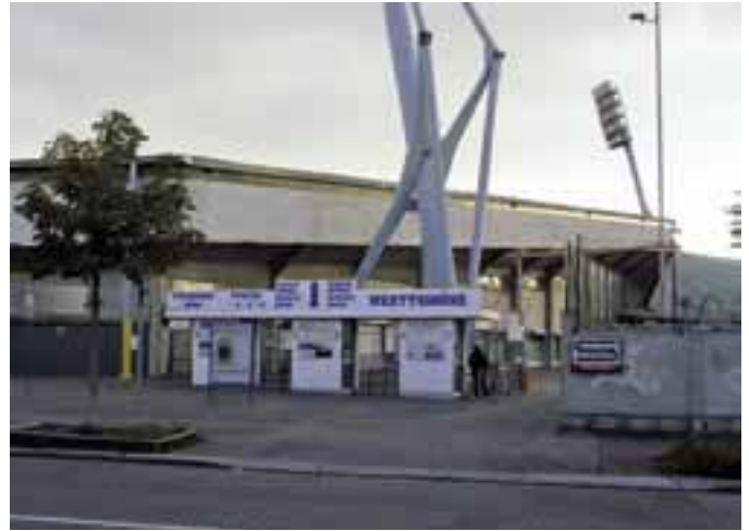
Hinter der Westtribüne haben bereits die Arbeiten für den Neubau begonnen.
