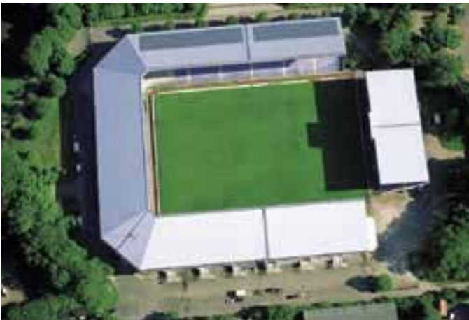
Solaranlage auf dem Dach der Südtribüne
