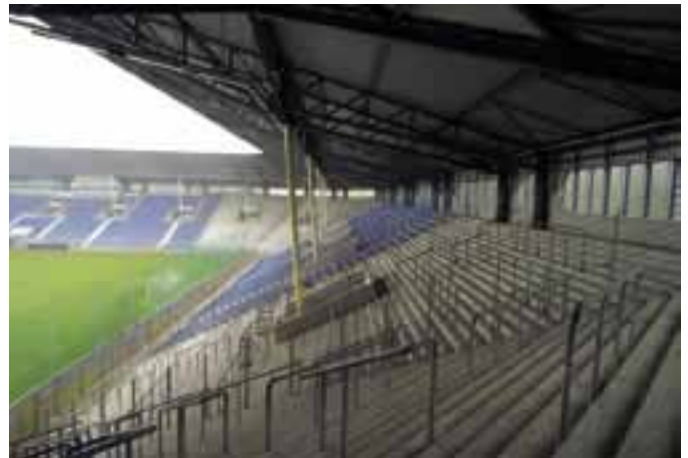
Streitigisch günstig in den Mundlöchern angeordnet: die Dachstützen
