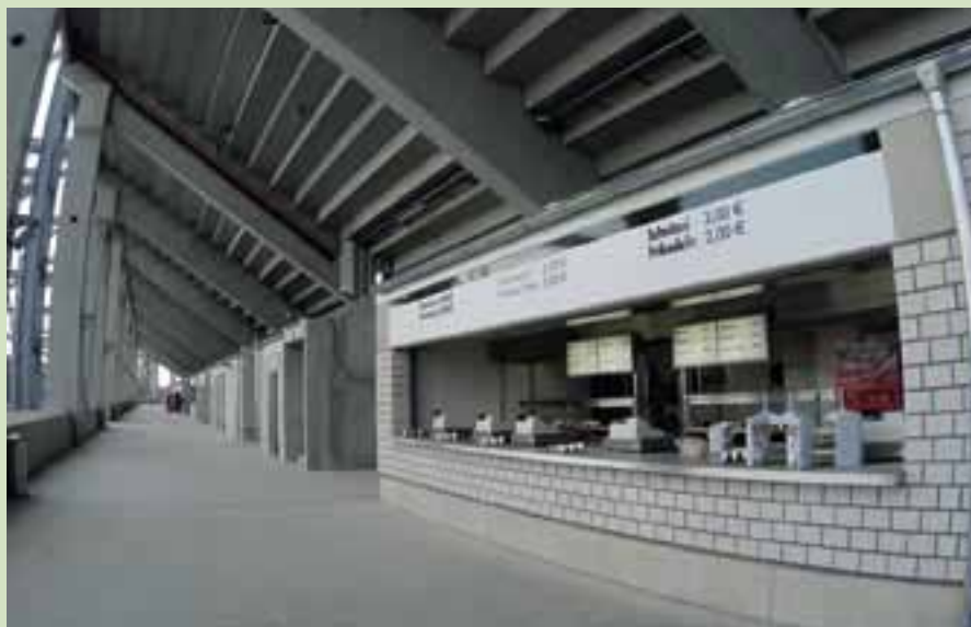
Kiosk auf der Umlaufebene...
